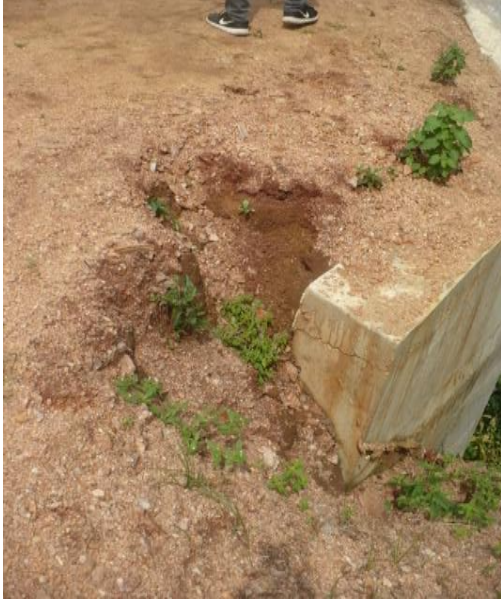
← වැව වාන් දමන අවස්ථාවේ වැව් බැම්ම බාදනය වීම. (ඡායාරූප අංක 05)
