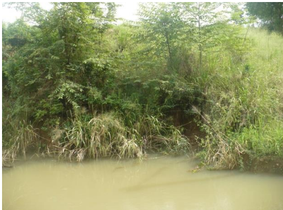
← වැව් බැම්මට පහළින් බාදනය වී තිබීම සහ ඇළ මාර්ගය සංවර්ධනය කර නොතිබීම (ඡායාරූප අංක 02)
