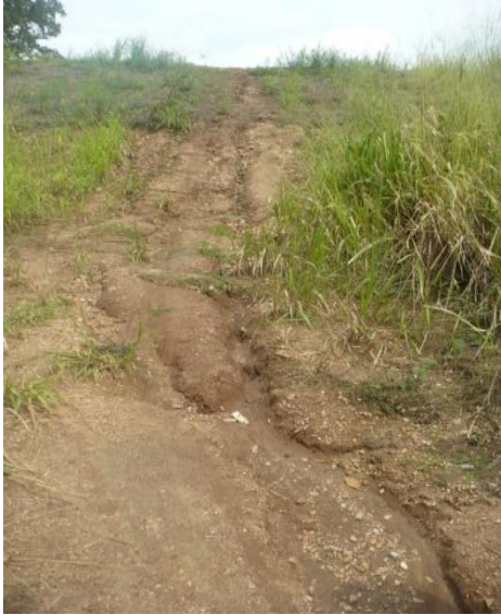
← වාහන ගමන් කිරීම නිසා වැව් බැම්ම බාදනය වී තිබීම (ඡායාරූප අංක 03)
