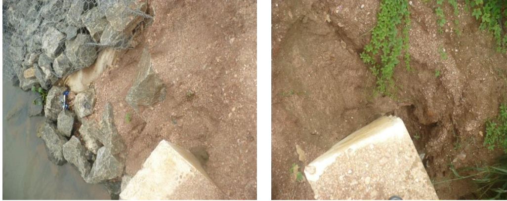
ප්‍රමිතියෙන් තොරව ඉදි කළ පිටවන දෙපස ආරක්ෂිත කණු හා වැව් බැම්ම (ඡායාරූප අංක 7)
