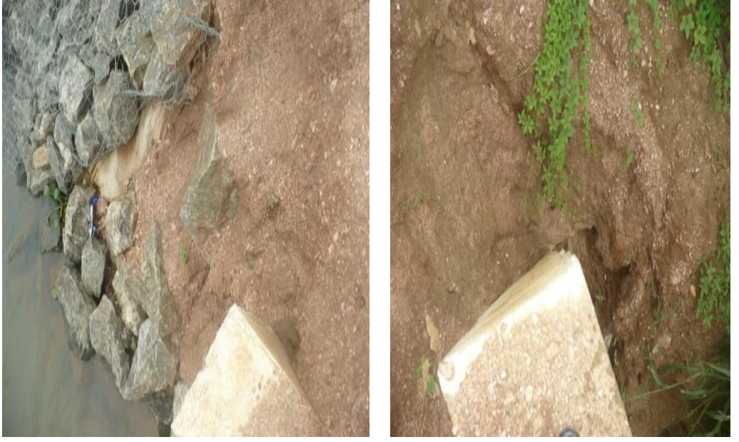
தரமின்றி நிருமாணிக்கப்பட்ட வழிப்படலை இருபக்கமாகவும் பாதுகாப்பு வடிகால் மற்றும் குளக்கட்டு (புகைப்பட இலக்கம் 07)
