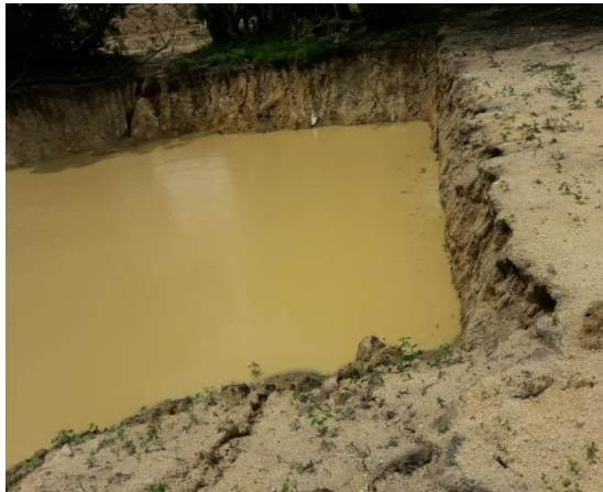
රූපසටහන 11- බෝගොඩ වැව අනුමත ගැඹුර ඉක්මවා වලවල් භාරා ඉවත්කර ගෙන ඇති අයුරු
