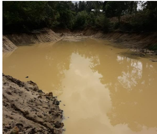
රූපසටහන 11- බෝගොඩ වැව අනුමත ගැඹුර ඉක්මවා වලවල් භාරා ඉවත්කර ගෙන ඇති අයුරු
